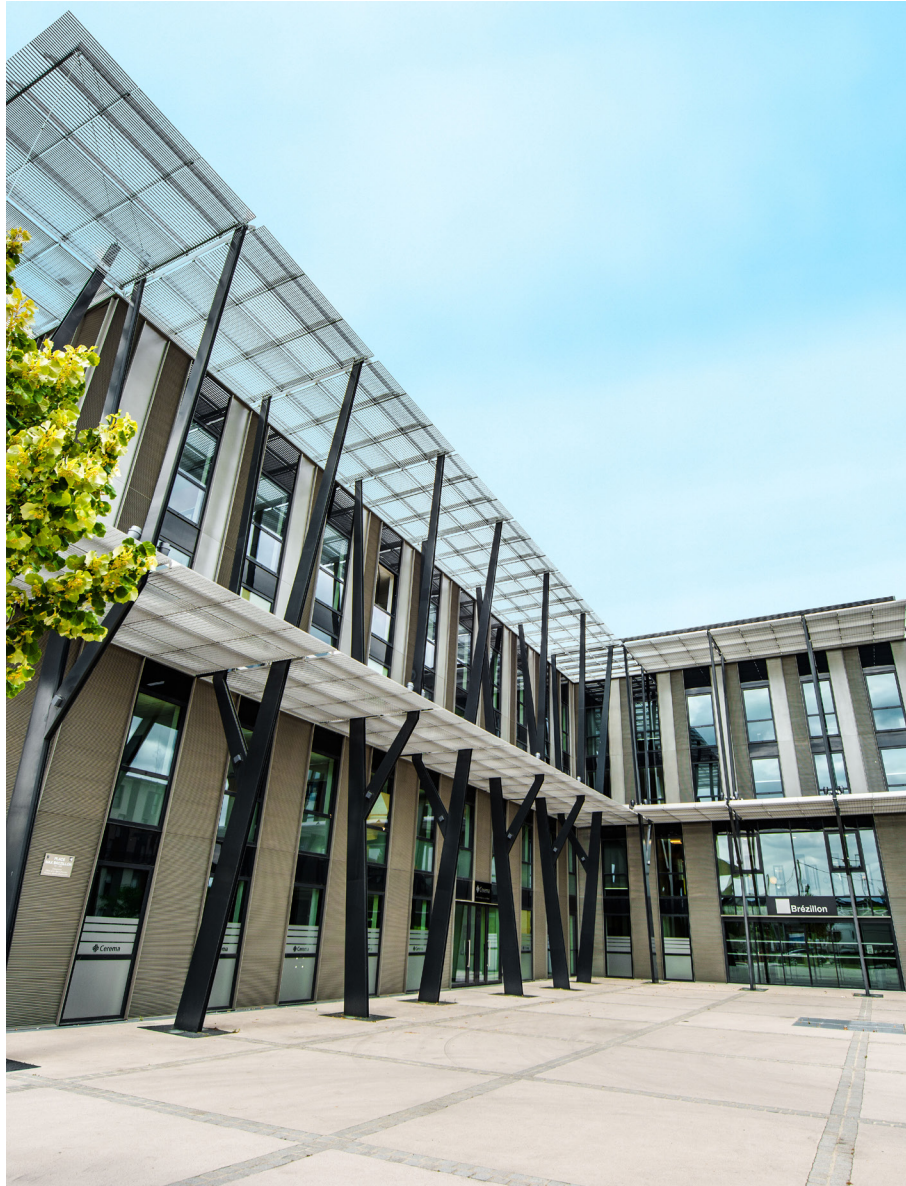
Rue de Beauvais - Margny-lès-Compiègne
