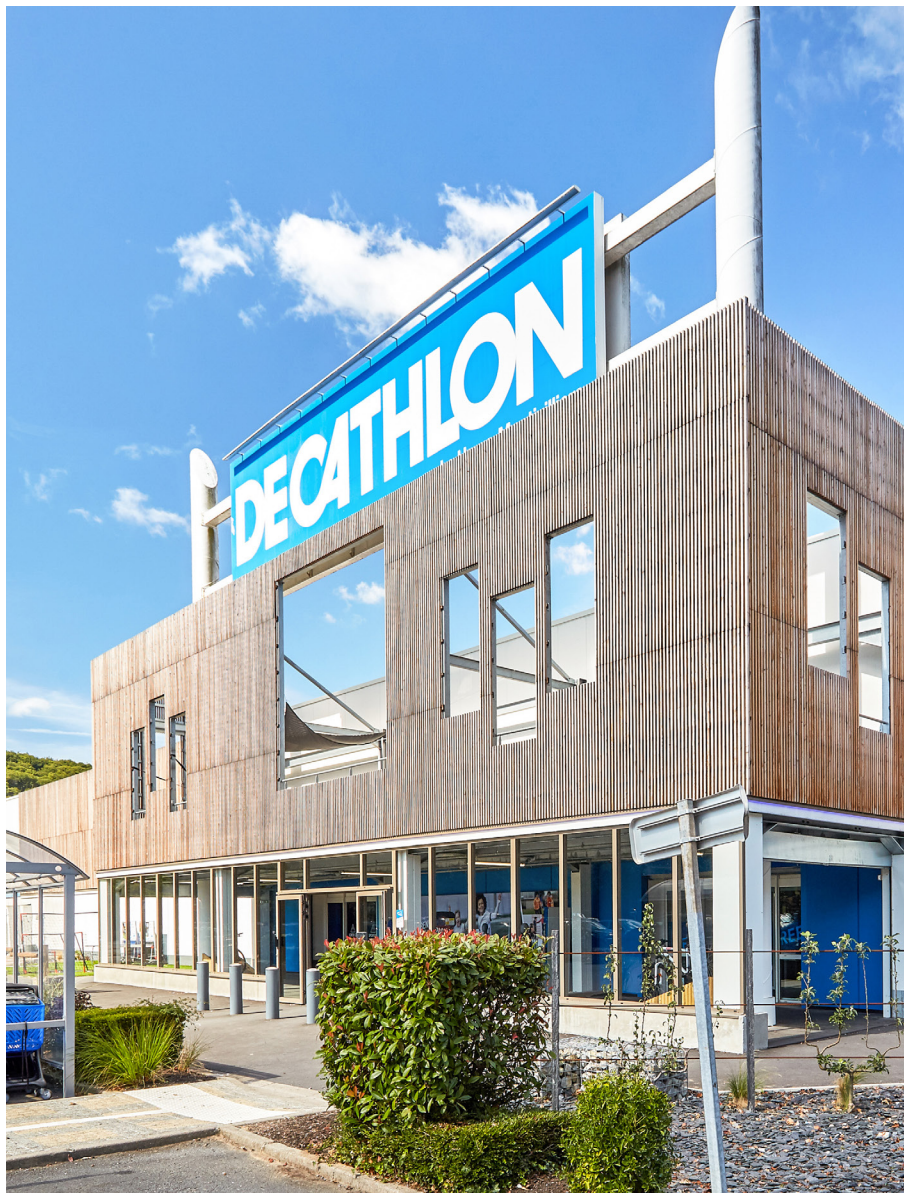
Centre commercial La Lézarde - Montivilliers (Le Havre)
