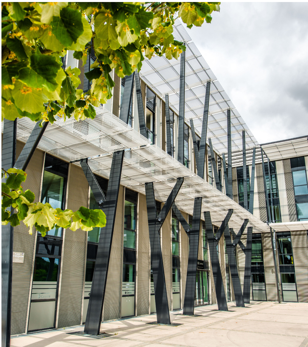
Rue de Beauvais - Margny-lès-Compiègne
