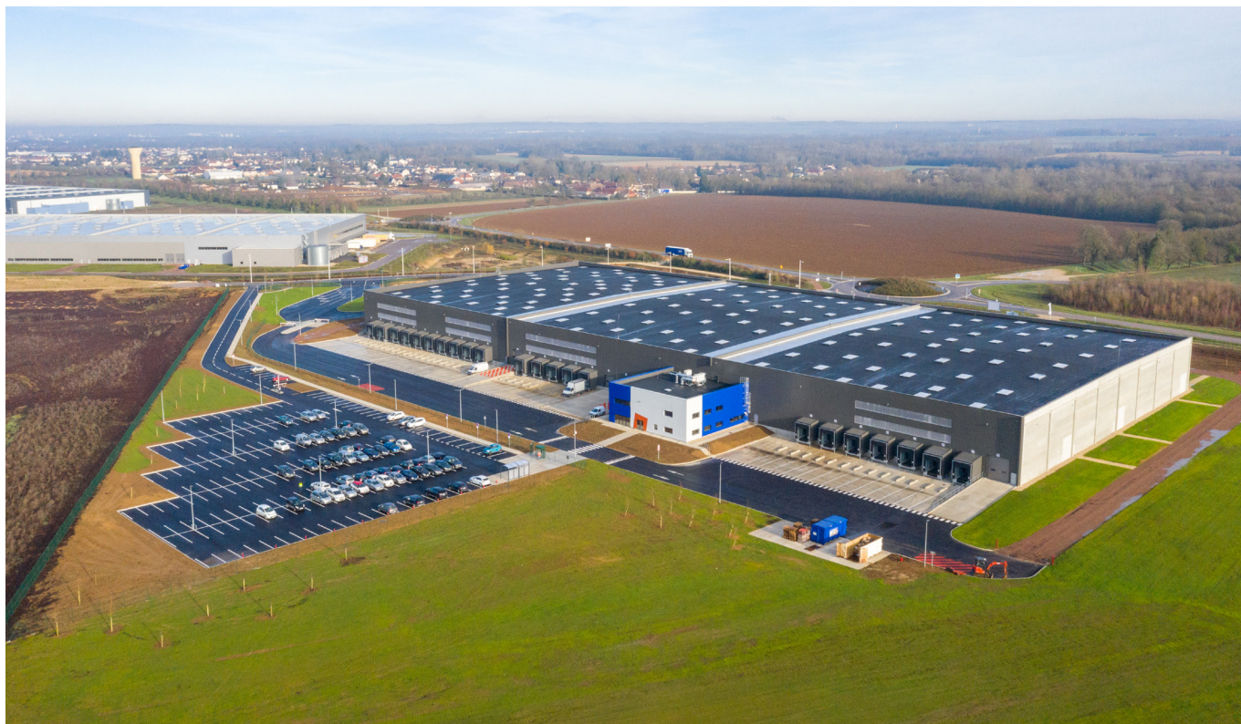
Zac du Parc Logistique de l'Aube - Troyes
